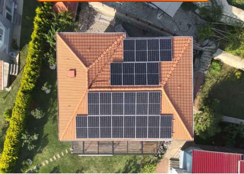
Erkan Yılmaz Ges / ADANA 12 kWp
